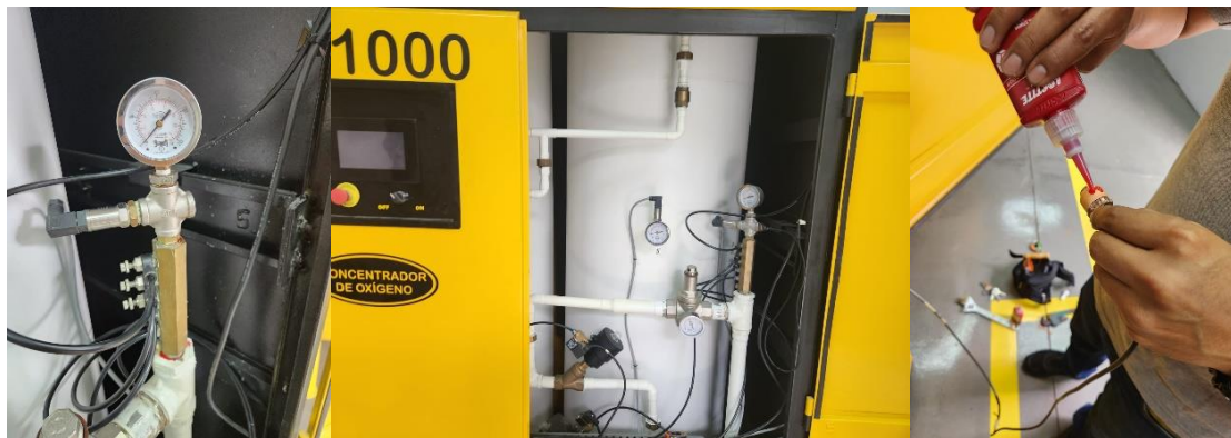
Ilustración 15: Reparación de sensor de oxígeno
