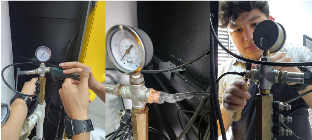
Ilustración 16: Proceso de sellado en la planta de oxígeno
