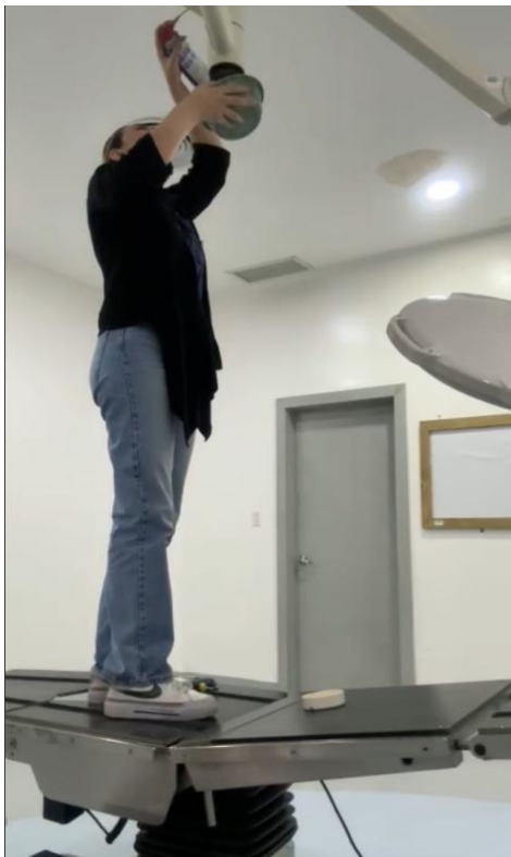
Anexos 6 Mantenimiento de Lampara Cielítica
