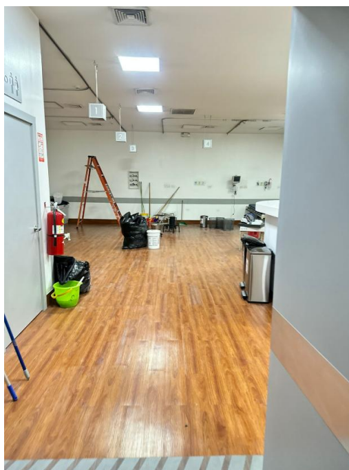
Ilustración 7 Remodelación de quirófano
