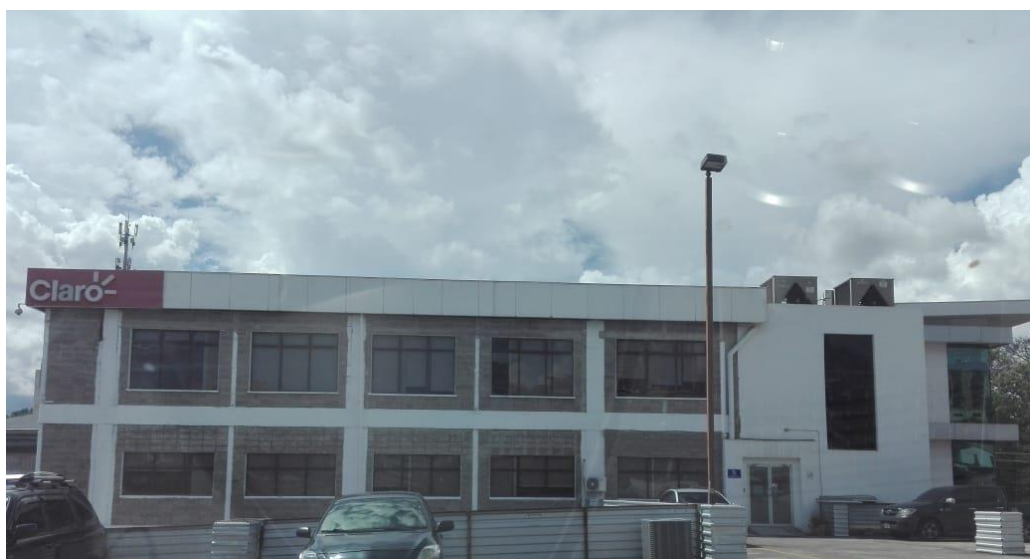
Figura 23. Techo de Sercom de Honduras, Edificio Castaños
