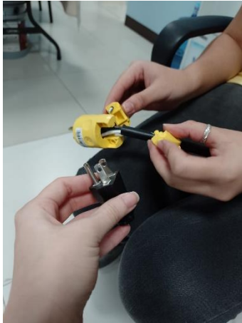
Ilustración 35 Cambio de conectores de cable de alimentación de UPS.
