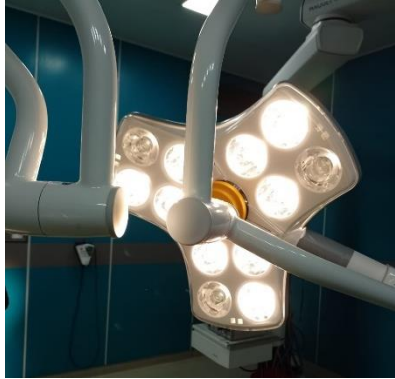
Ilustración 14 Lámparas cirúrgicas con bombillos no funcionales en quirófanos.
