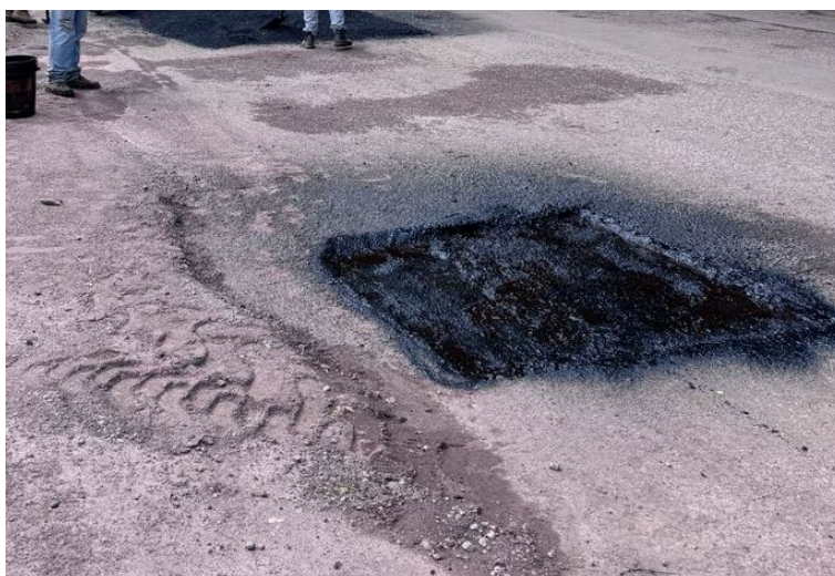
Ilustración 11 Imprimación de baches
