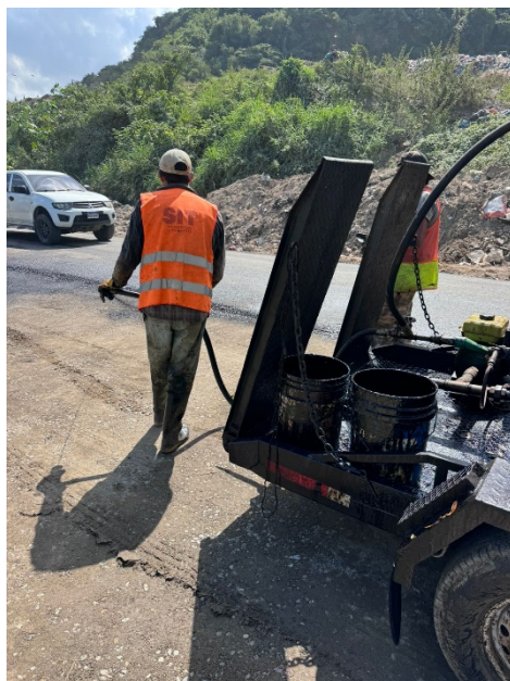
Ilustración 10 La cocina, con lo que se riega la emulsión y se mantiene a la temperatura adecuada.
