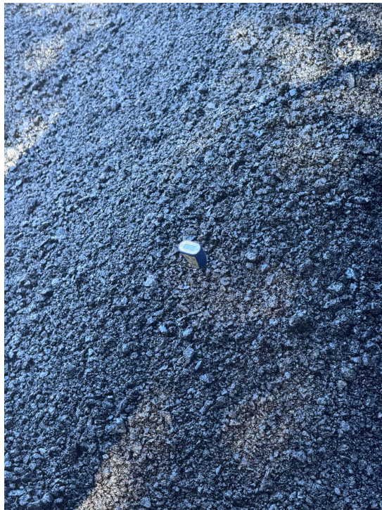
Ilustración 14 Medición de temperatura de la mezcla
