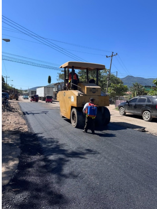
Ilustración 16 Sellado de la mezcla
