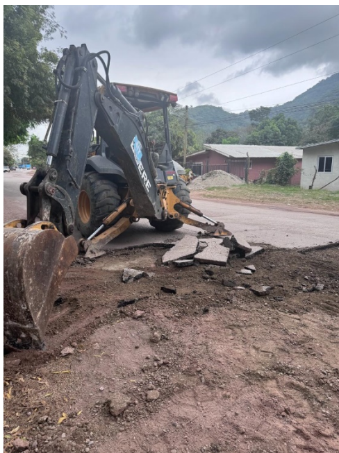
Ilustración 8 Excavación de baches
